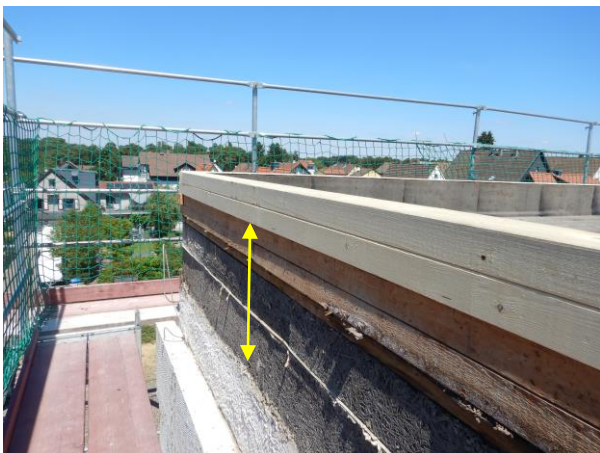
80cm Eternitverkleidung mit 2,5 bis >4cm Zwischenraum
