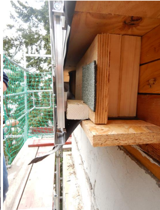
Der eigentliche Quartierbereich ist der Raum zwischen Isolierung (Holz/Dämmmaterial) und Dachlatte.
