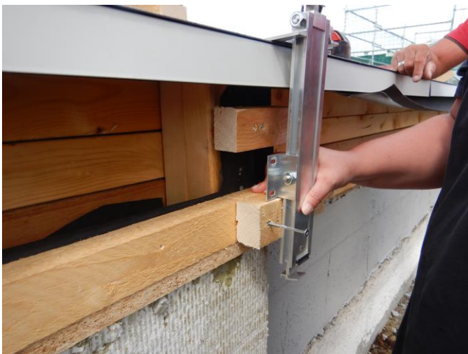
Quartierbereich ohne Vlies, nur mit sägerauen Verschalungsbrettern konstruiert.
