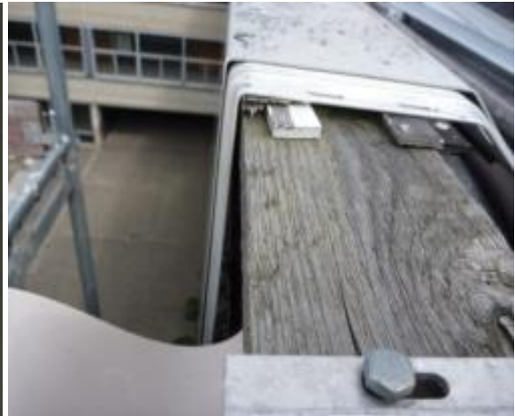
Der Zwischenraum zwischen Blechabdeckung und Holz (Mauerkrone) sowie zwischen Fassade und Blech diente als Quartier.
